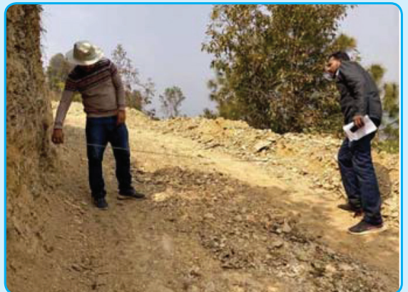
जिलिम खोला सडक निर्माण कार्य वडा नं ०४
