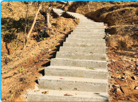
वाडा नं ६ Foot trail निर्माण
