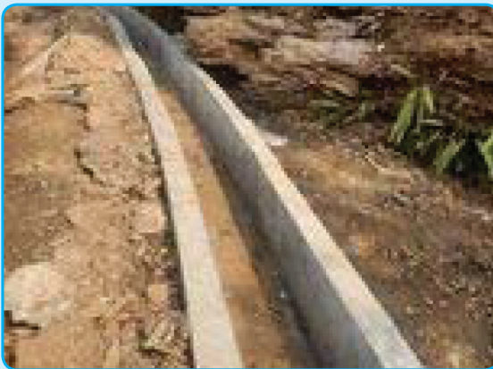
वडा नं २ सिंचाई कुलो निर्माण
