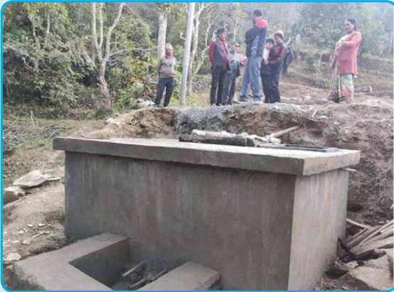
वार्ड नं ०७ ट्याङ्की निर्माण
