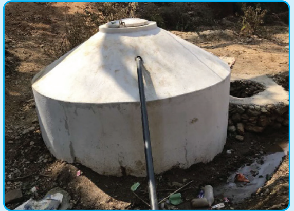
वार्ड नं ०४ ट्याङ्की निर्माण
