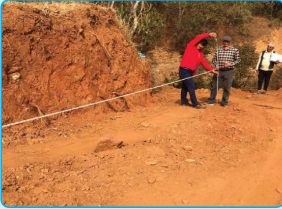
वाडा नं ६ नयाँ ट्राक निर्माण
