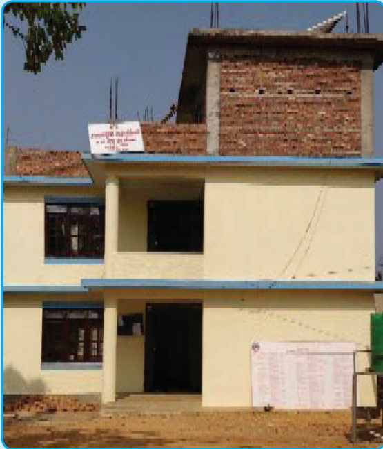
वडा नं. १ को कार्यालय भवन
