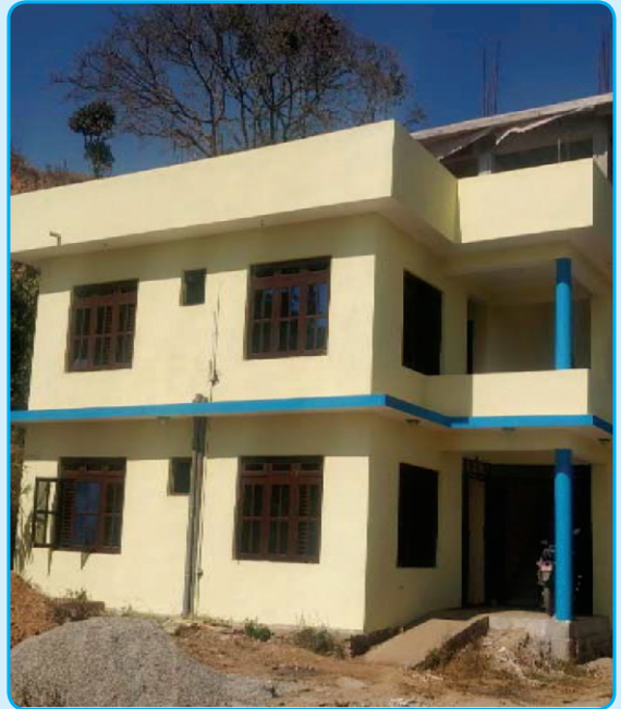
वडा नं. ३ को कार्यालय भवन
