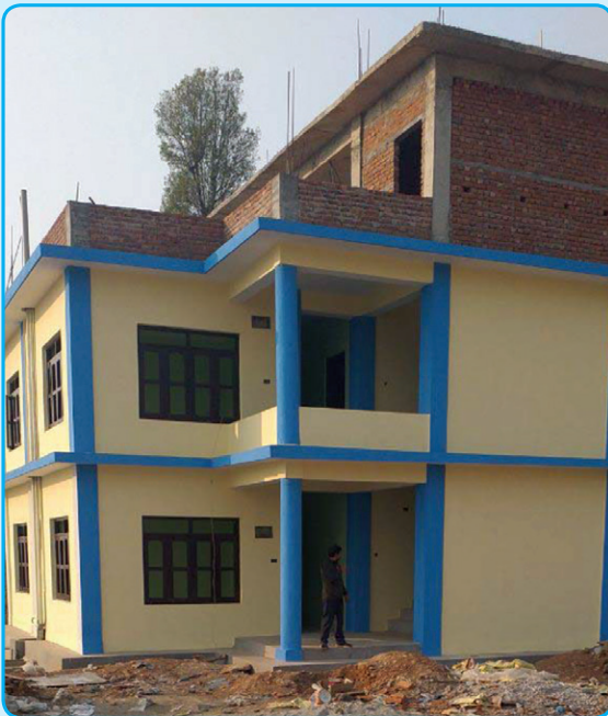
वडा नं. ६ को कार्यालय भवन
