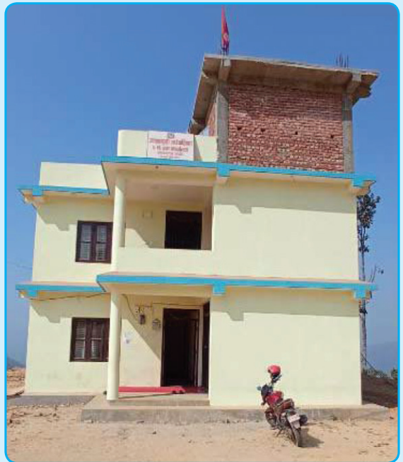
वडा नं. ७ को कार्यालय भवन
