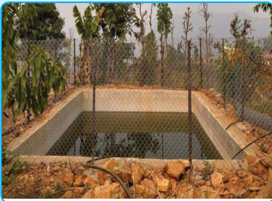
वडा नं २ सिंचाई पोखरि निर्माण
