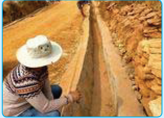
दोबानटार मिलनचोक सडक नाला निर्माण वडा नं ०४
